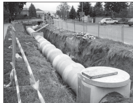
Kanalizace byla položena do koryta původního potoka.
