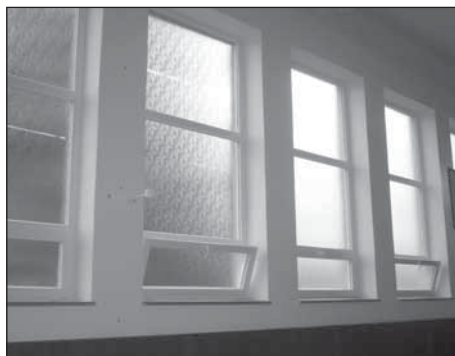
Nová plastová okna v tělocvičně
