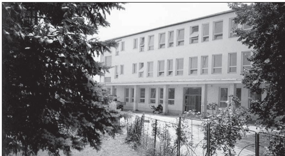
Pavilon v provozu - rok 1994
