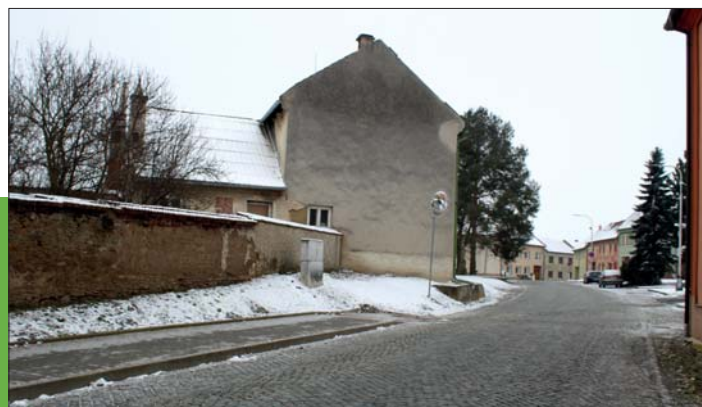
Současný pohled na roh domu čp. 16 (v ulici U Kapličky). Foto: Karel Mišák
