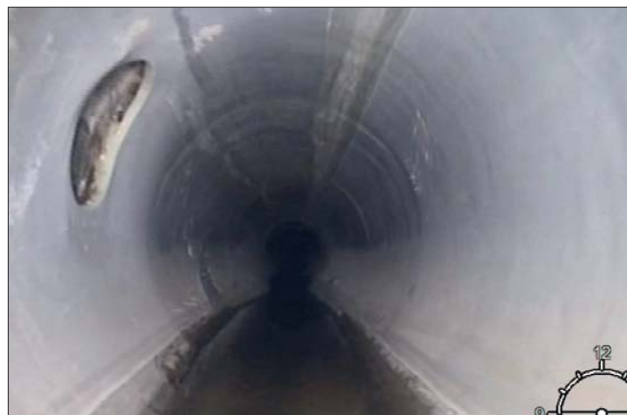
... a po opravě.
