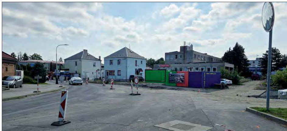
Práce na budoucí křižovatce k retail parku vrcholí.
