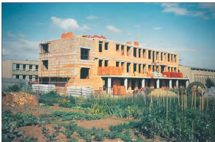
Stavba nové budovy pro druhý stupeň ZŠ.
