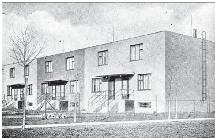
Dům čp. 120 po dostavbě.
