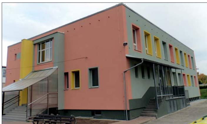
Budova školní družiny a jídelny v novém „kabátě“.
