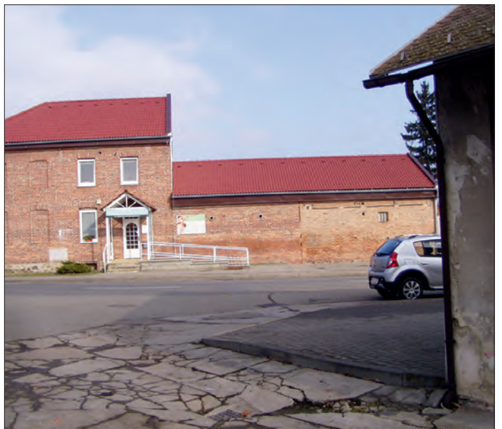
Po loňské výměně střechy.
