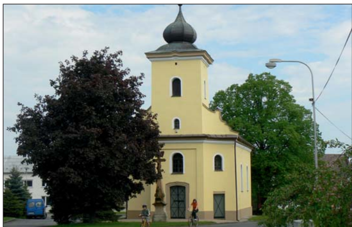
Nový nátěr fasády kaple sv. Floriána.
