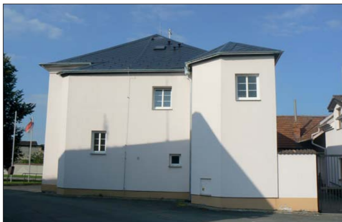
Nová střecha na budově KSZ.
